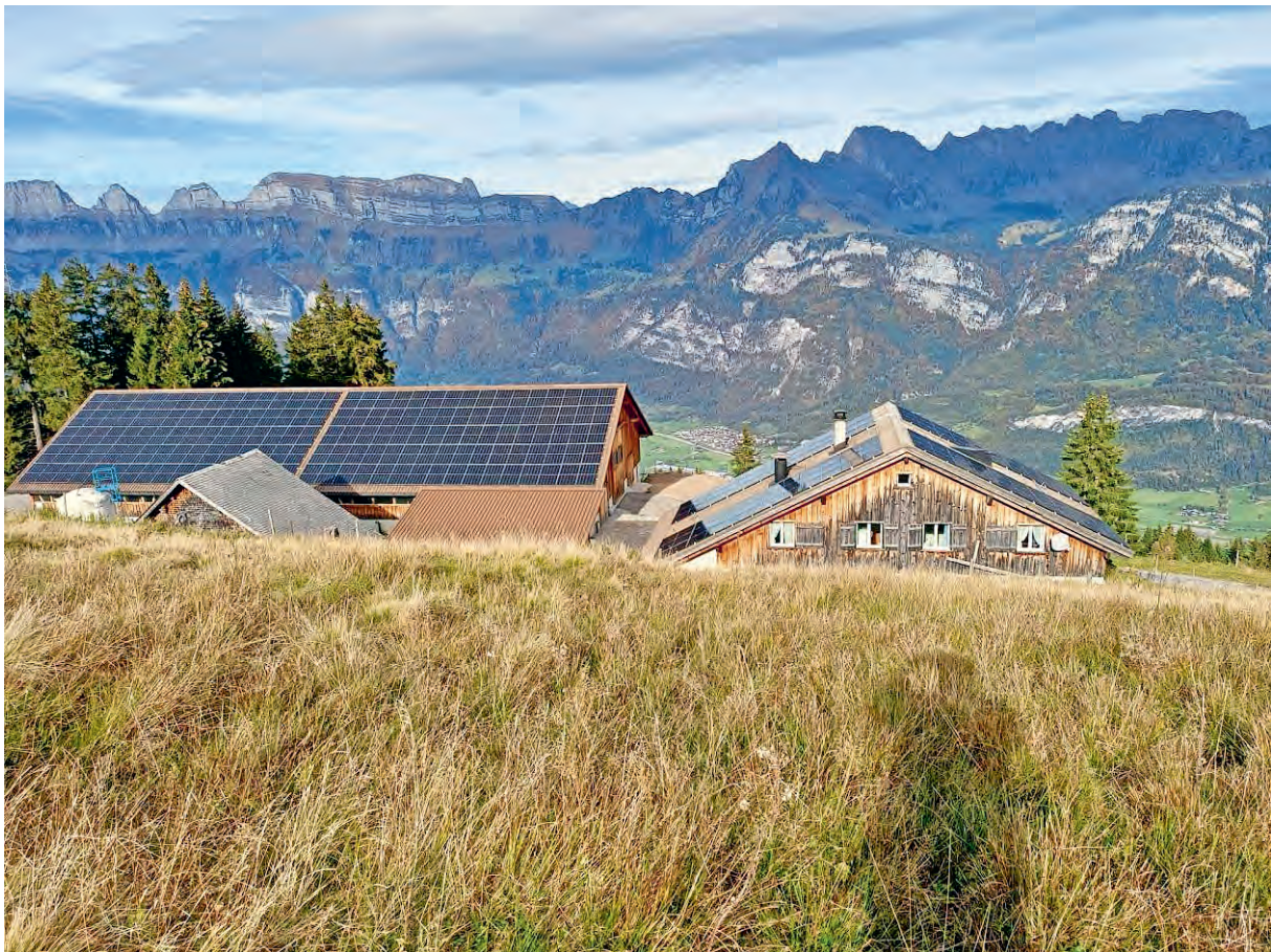
Die neue 100 kWh PV-Anlage auf der Alp Wildenberg der Energie-Genossenschaft PizSol
