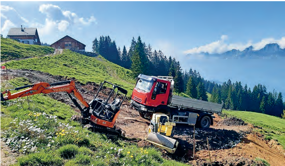
Einbringung des Koffermaterials auf der Umlegung des Gafröenwegs
