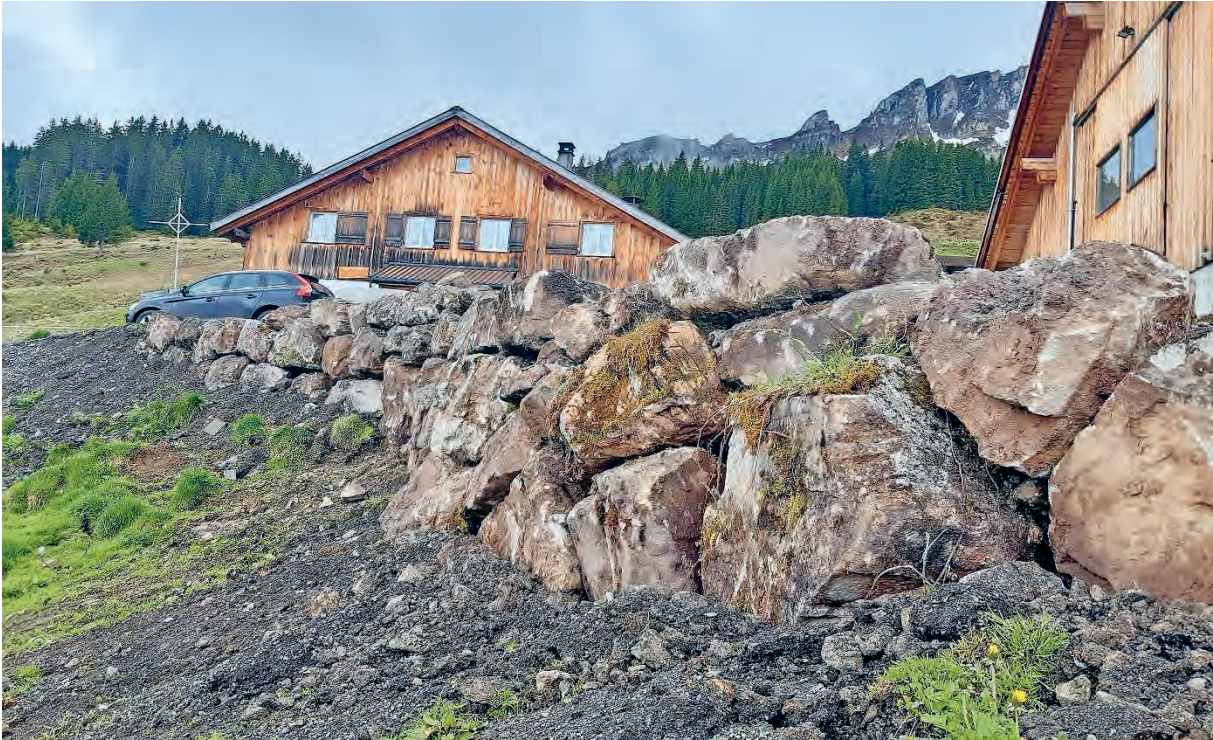
Abschlussarbeiten für die Vorplatzterweiterung im Endspurt, eine gelungene Sache
